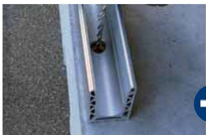
Učvršćivanje profila - podno
